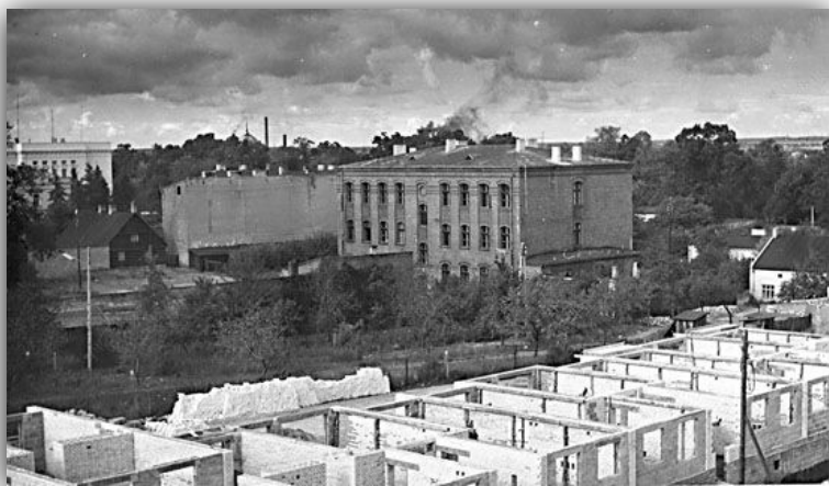
Budowa bloku Osiedla Zapiecek
